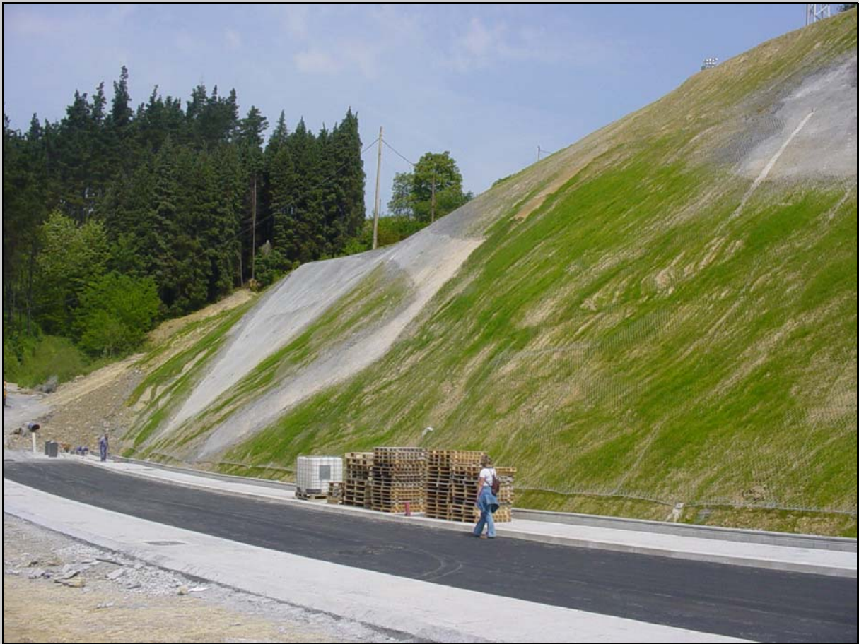
Talud urbanización Aldapa Oeste. Gobierno Vasco (Ermua)
