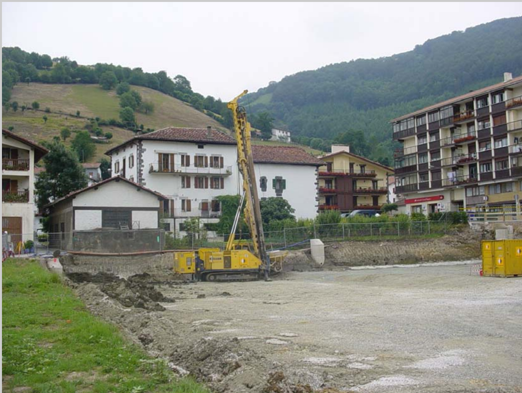
columnas de grava (Leitza. UR-5 Sagastimarrea, 2003)
